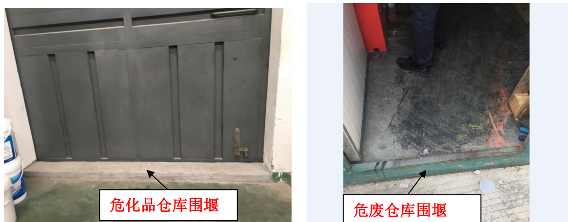
图 3-4 危化品仓库和危废仓库围堰
